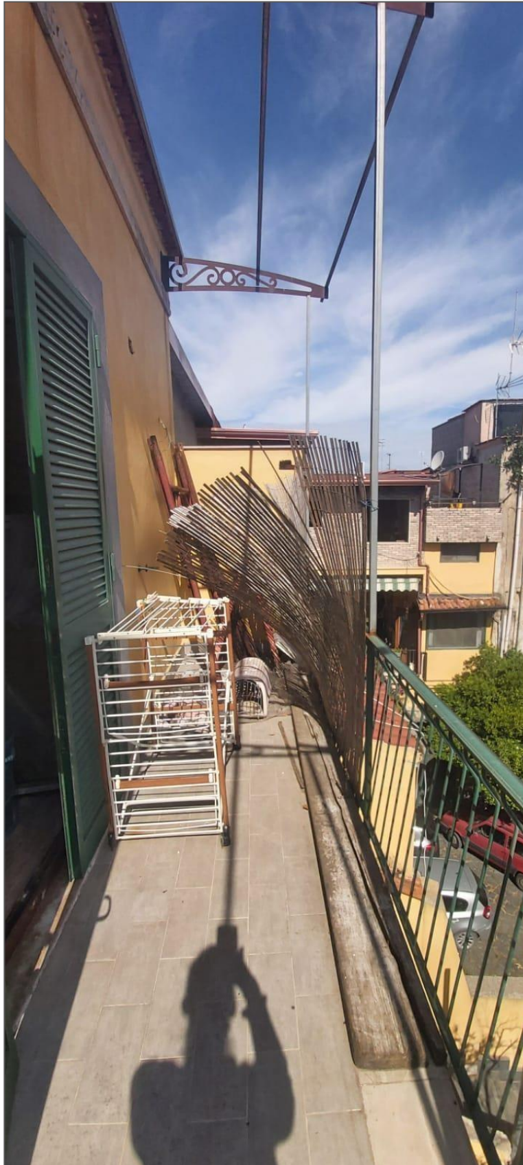
LOTTO UNICO (Piano secondo)- Vista del balcone
